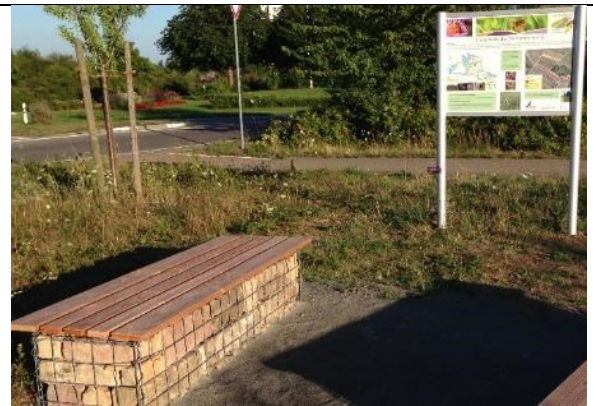
Gabione mit Buntsandsteinen und Sitzauflage, © M.Deubert
